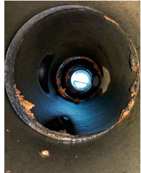
Abb. 1: Gelblich-weiße, verklebte Mehlreste an den Muffen eines T-Stücks in einem Trinkwasserrohr
